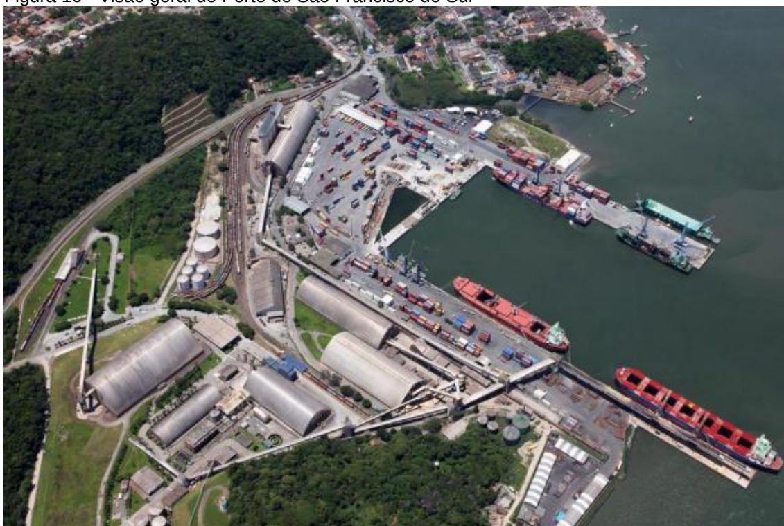
Figura 16 - Visão geral do Porto de São Francisco do Sul
