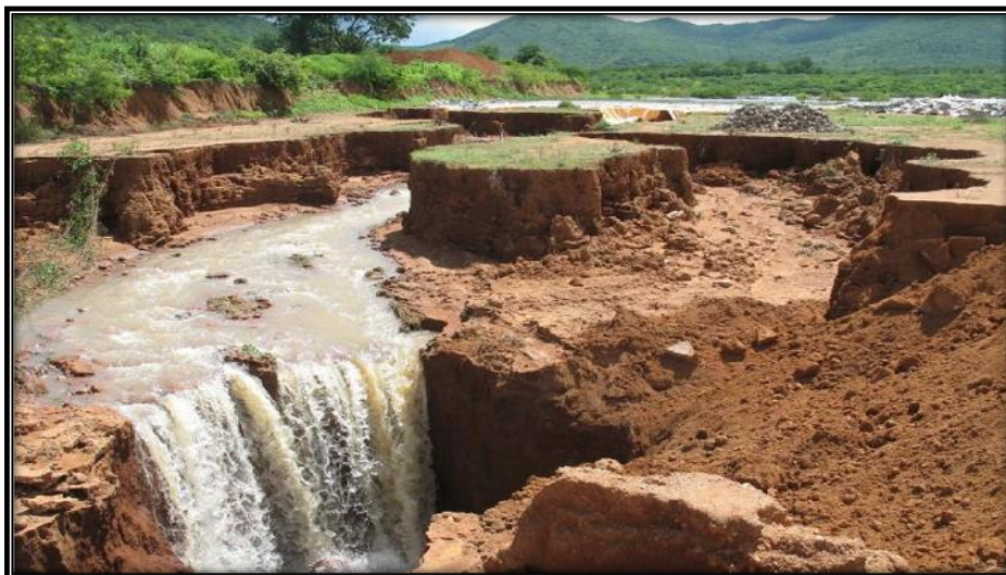
Figura 6 - Erosão dos solos
