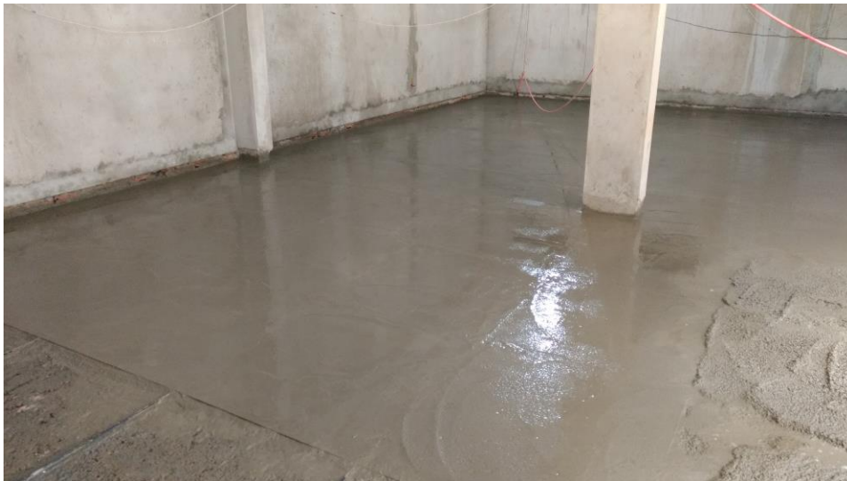
Figura 6 – Aplicação da Argamassa
