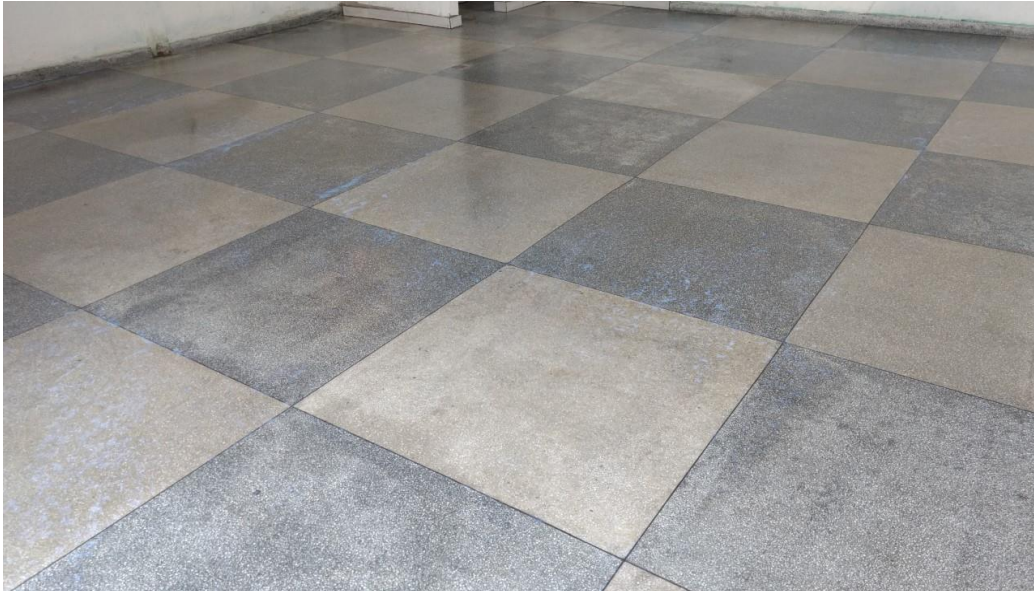
Figura 4 – Piso de Granilite
