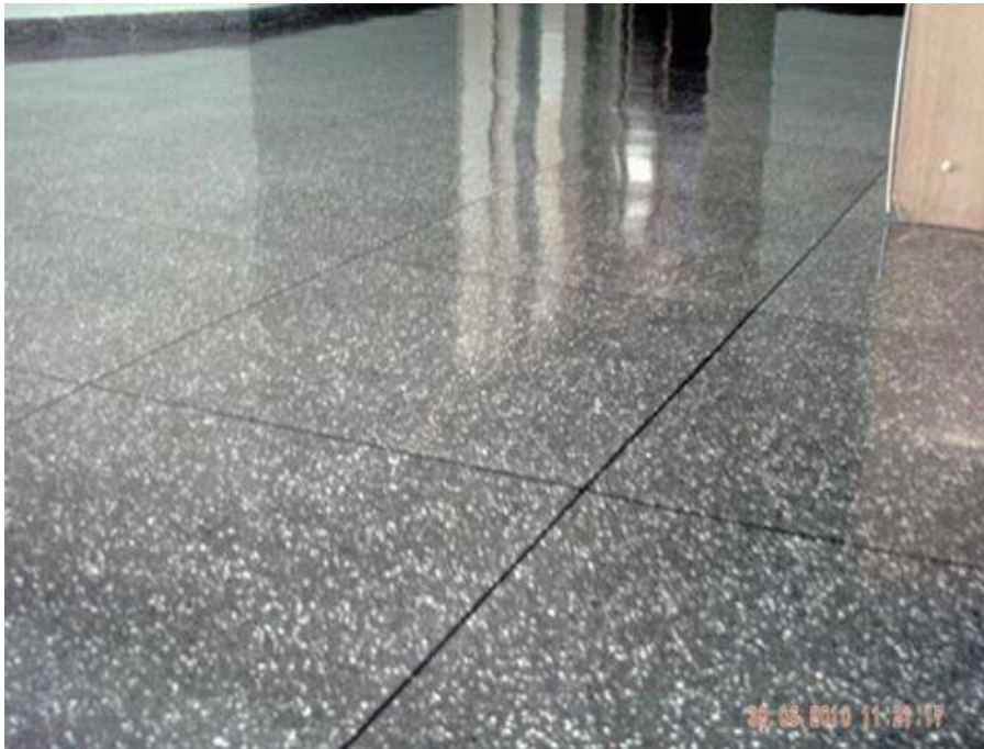
Figura 3 – Piso de Granilite.
