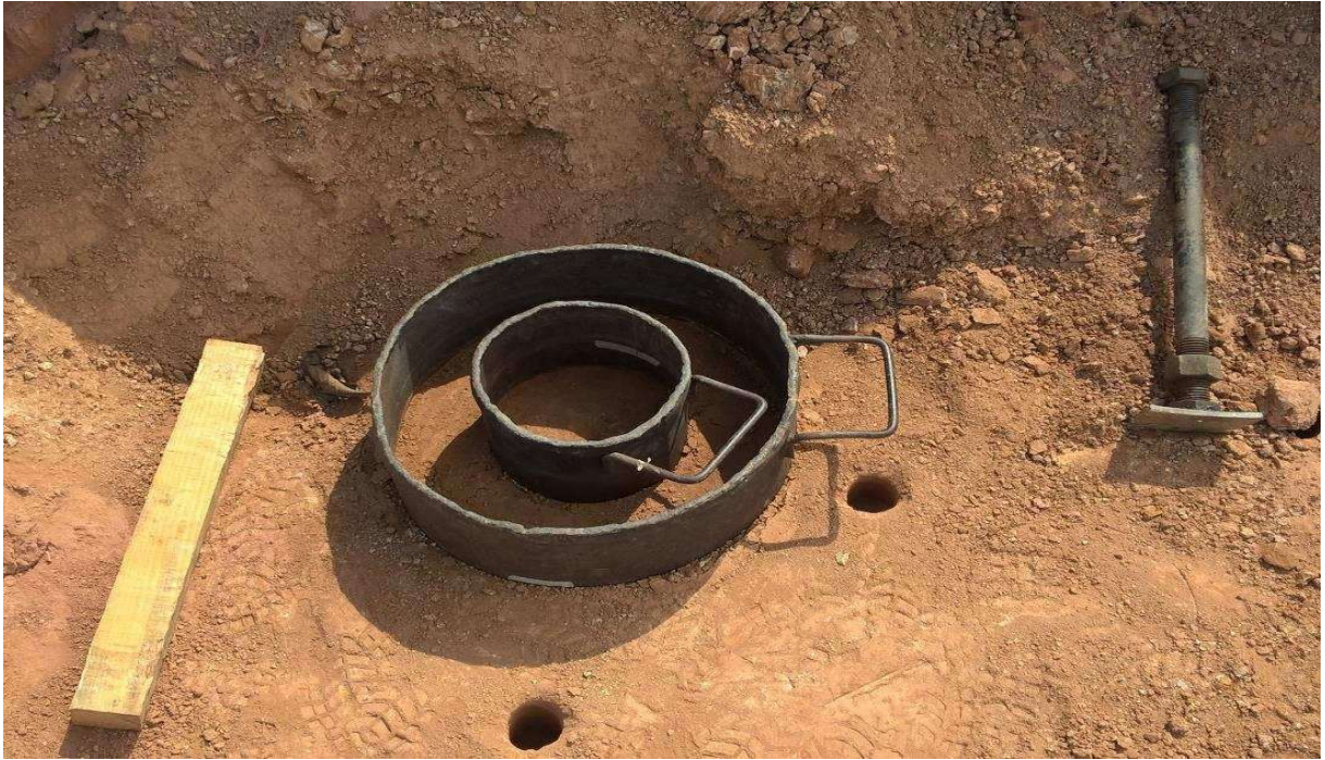
Figura 8- Instalação do infiltrômetro de anéis concêntricos
