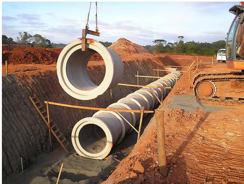
Figura 3 – Tubulação de concreto para águas pluviais
