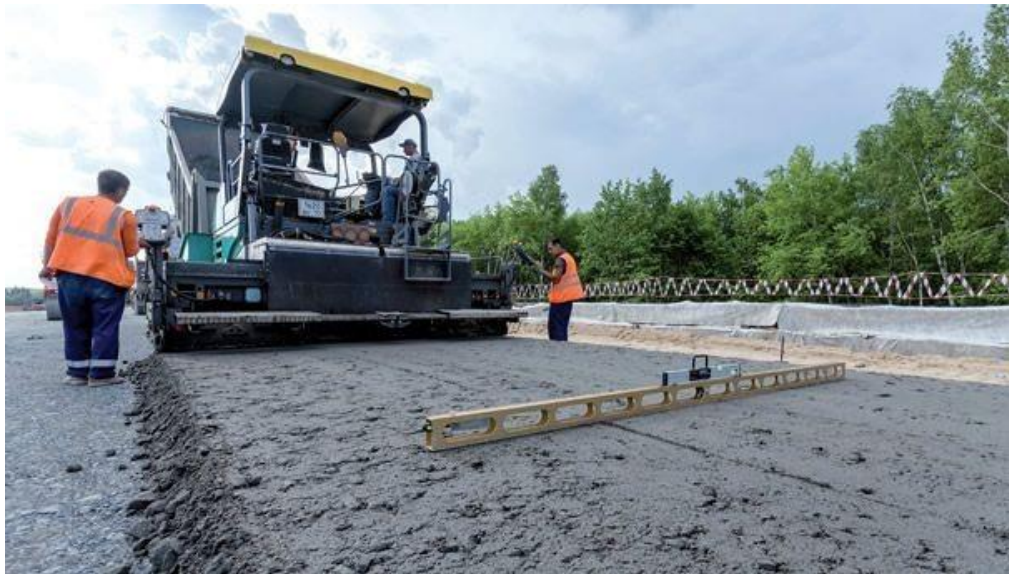
Figura 2 - Recuperação e reforço de um pavimento flexível
