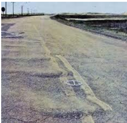
Figura 10 - Ondulações e Corrugações
