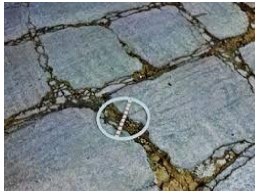
Figura 7 - Trinca "Bloco"
