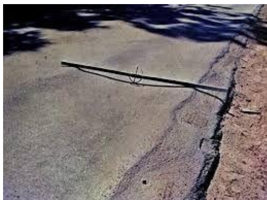
Figura 8 - Afundamento Plástico
