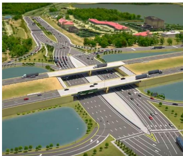
Figura 2 - Exemplo de interseção em desníveis
