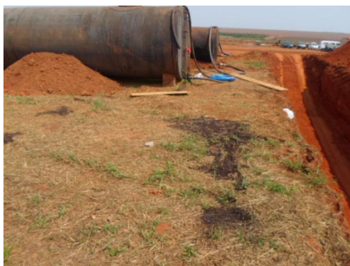
Figura 2 – Armazenamento de material asfáltico.
