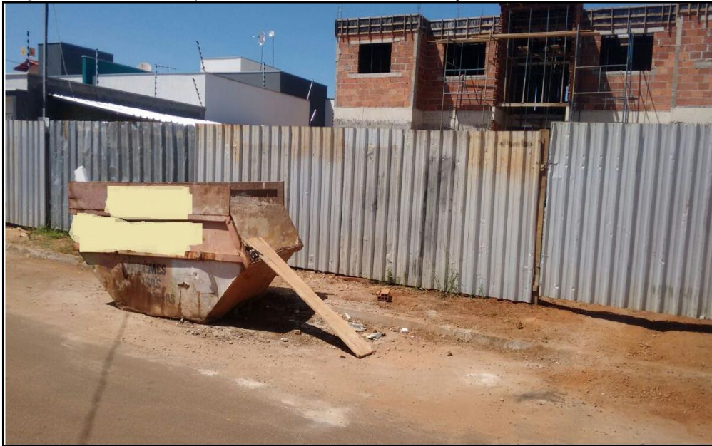
Figura 15-Local de depósito dos resíduos da construção civil
