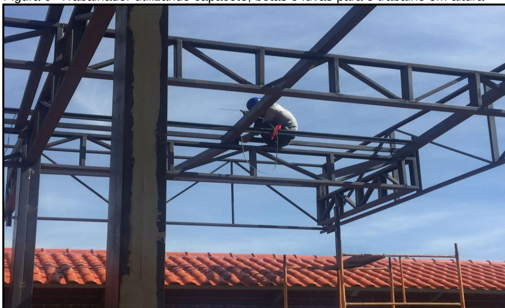
Figura 9- Trabalhador utilizando capacete, botas e luvas para o trabalho em altura
