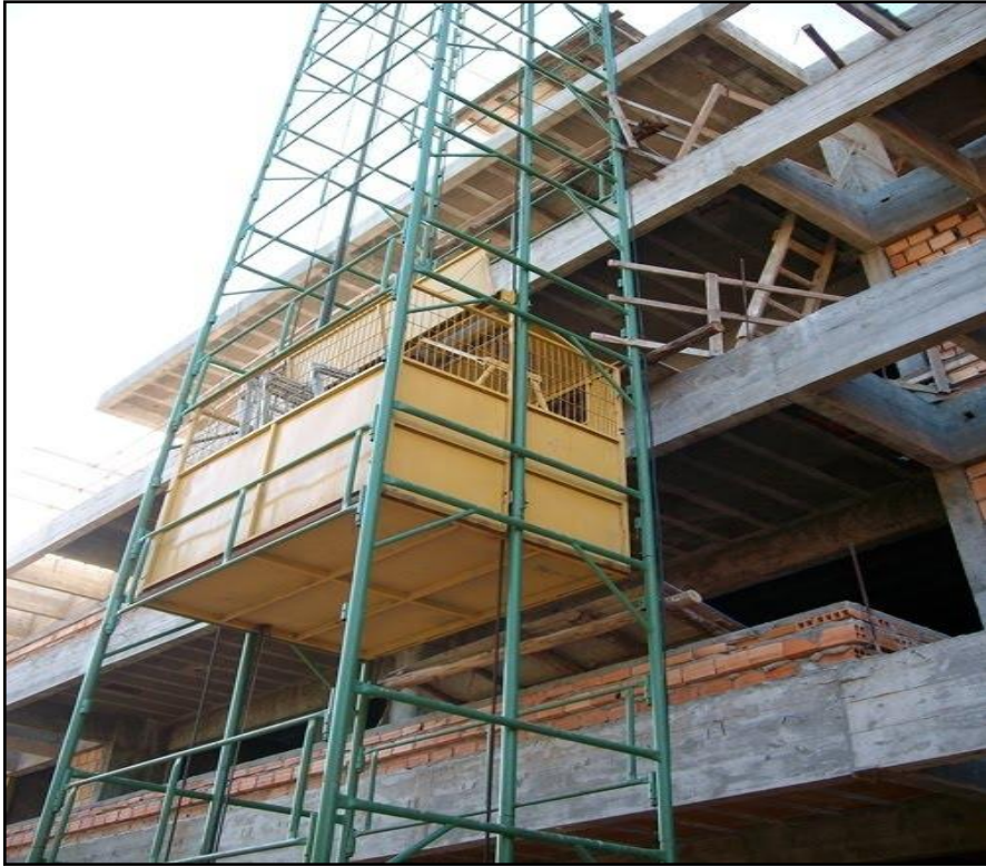
Figura 7- Exemplo de elevador na obra de construção civil
