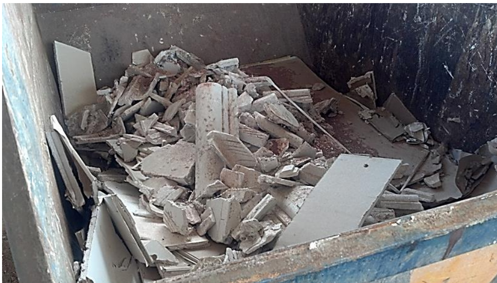
Figura 10 - Seletividade de resíduo do gesso acartonado Fonte: Providência, (2017)
