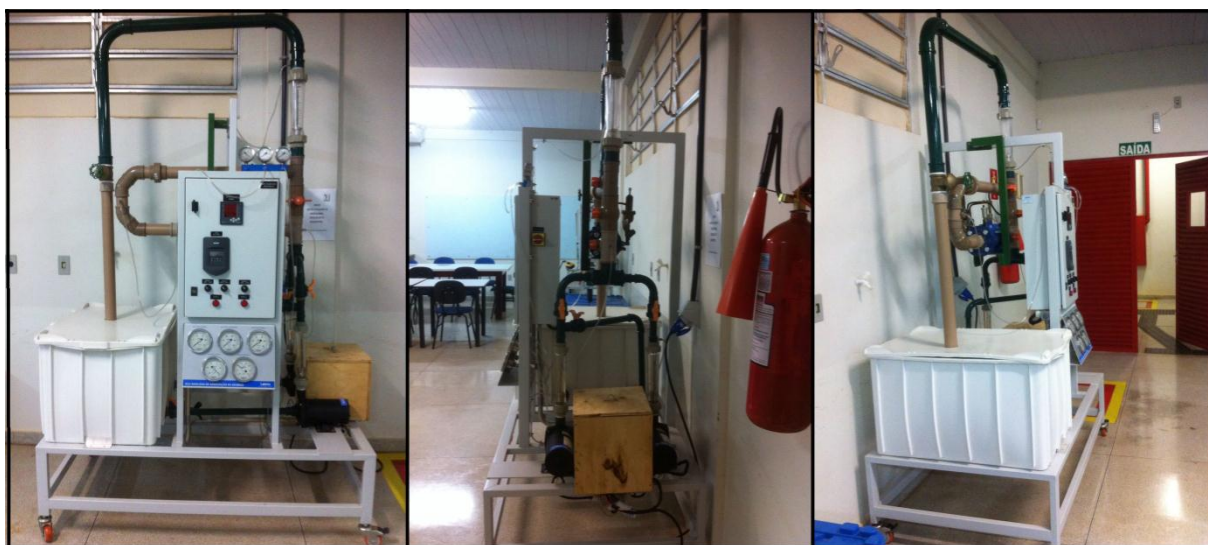
Figura 3 - Válvula Redutora de Pressão instalada na Bancada de Associação de Bombas. Fonte: AutoriaPrópria, (2017).
