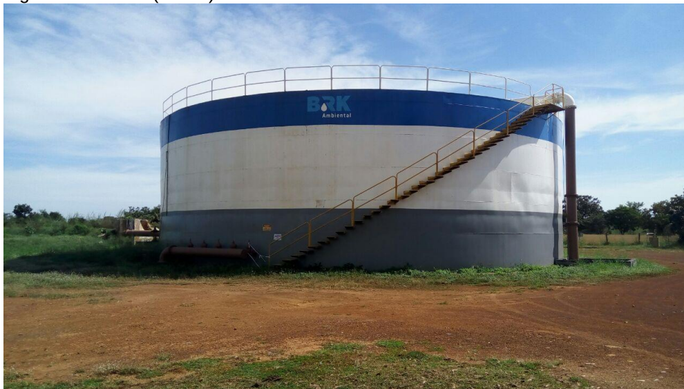
Figura 7 – Reator (UASB) de tratamento anaeróbio e fluxo ascendente
