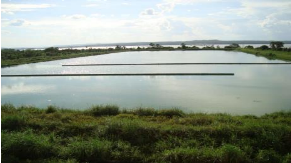
Figura 8 – Vista geral das lagoas facultativa e de maturação
