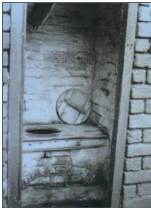
FIGURA 2 – Latrinas externas ao edifício. Fonte: Aro (2005).
