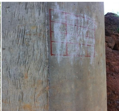
Figura 12– Gabarito no Pilar Fonte: Autor(2018)
