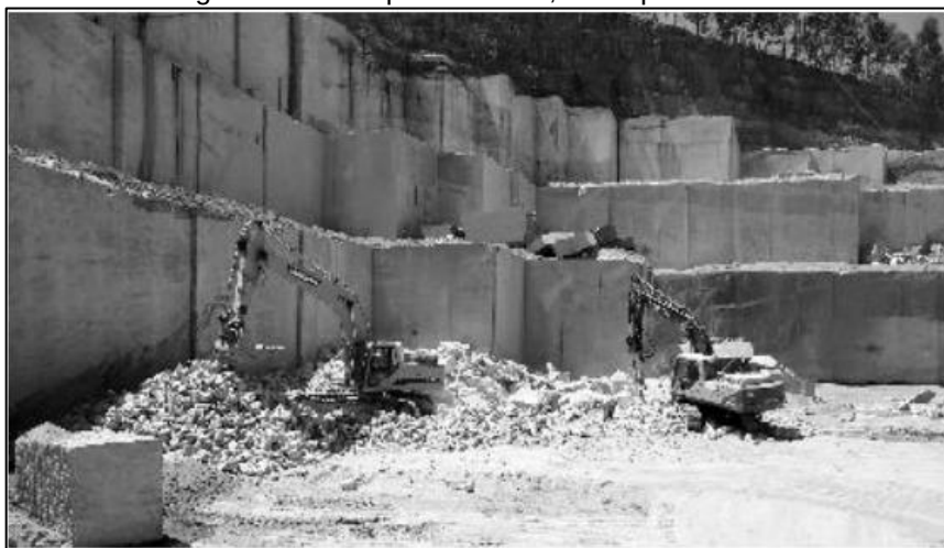
Figura 1 - Lavra por bancada, no Espírito Santo
