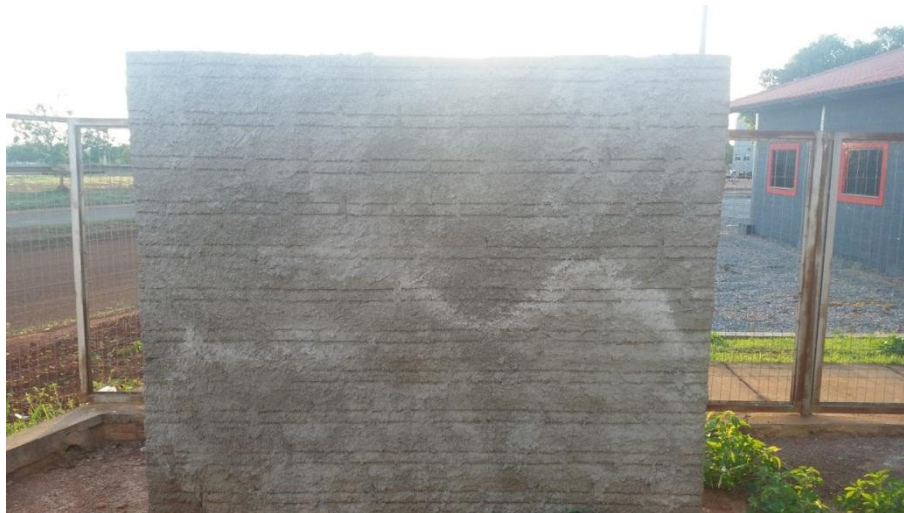
Figura 2 – Parede de alvenaria chapiscada
