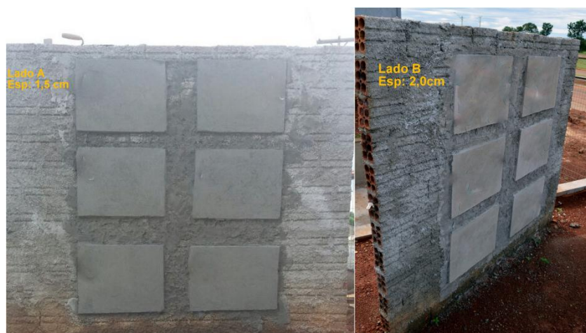
Figura 4 – Painéis de argamassa na parede de alvenaria
