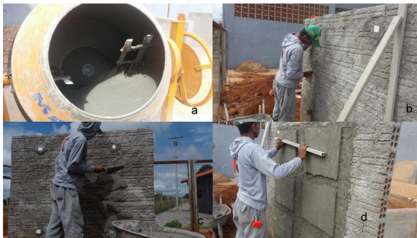
Figura 3 – Homogeneização da argamassa (a); colocação das taliscas cerâmicas (b): lançamento da manual da argamassa de revestimento (c); desempenho dos painéis de argamassa.
