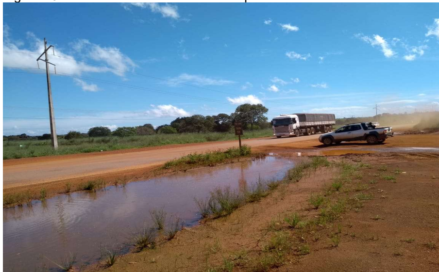
Figura 26 - Vista térrea de acesso ao Parque Industrial de Porto Nacional -TO
