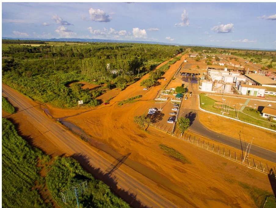
Figura 25 - Vista aérea de acesso ao Parque Industrial de Porto Nacional -TO
