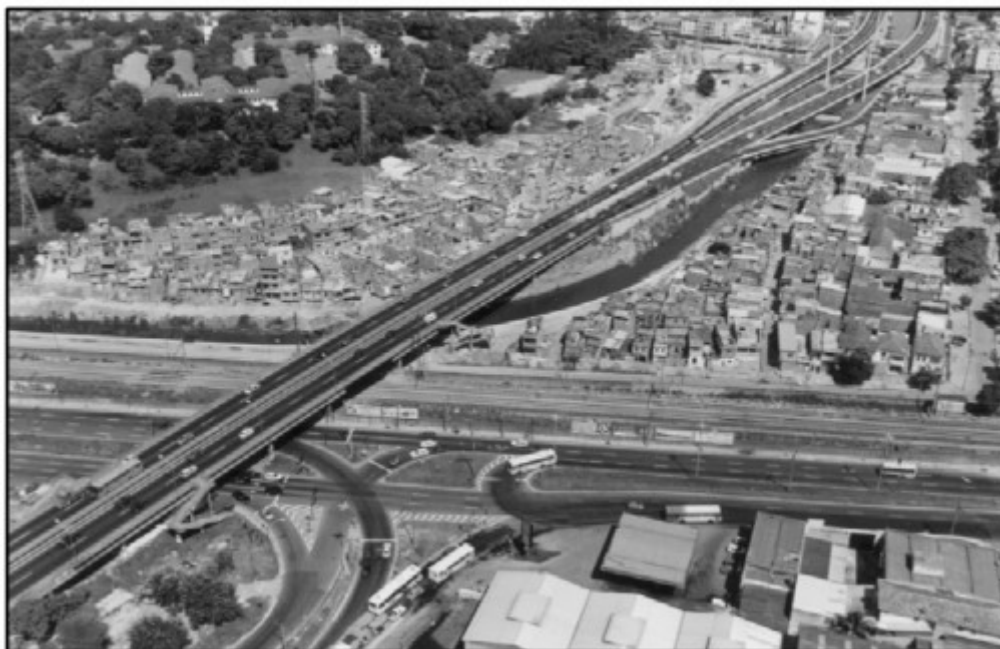
Figura 6 - Interseção com Sinalização Semafórica
