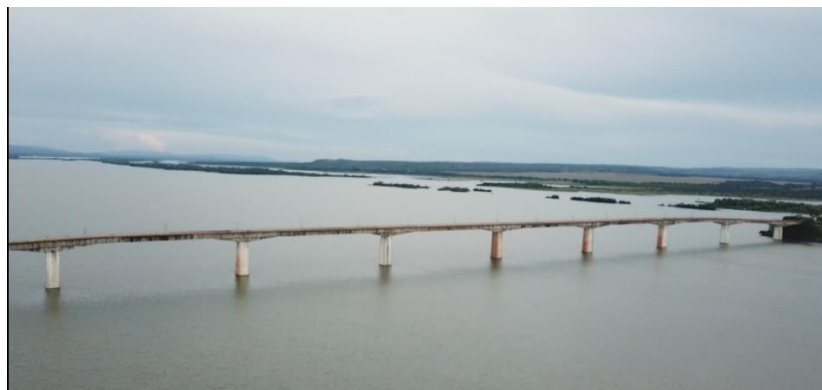
Figura 15 - Vista lateral da ponte
