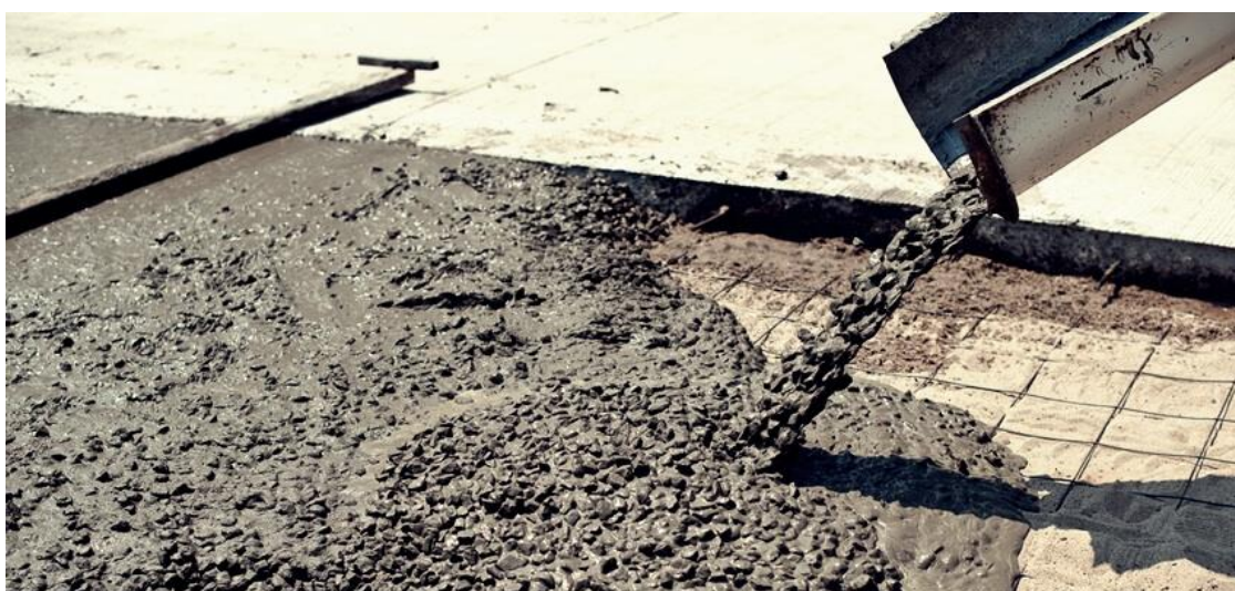
Figura 1 - Concretagem de uma laje
