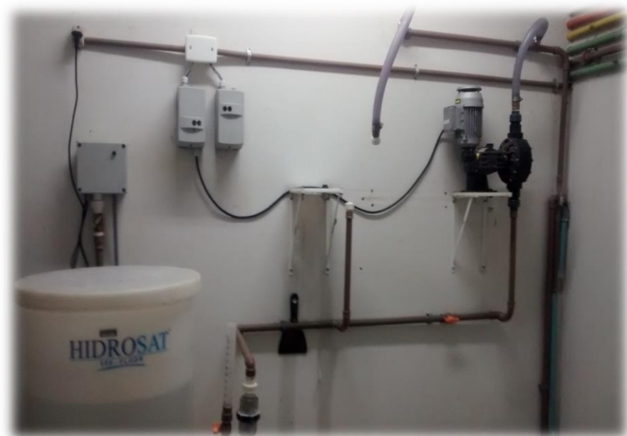
FIGURA 9 - Caminho percorrido pelo fluoreto, passando pelo dosador, que regula a quantidade de flúor que será liberada na água para consumo.
