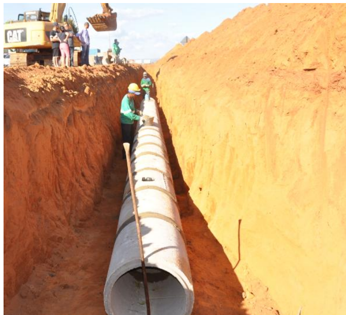
Figura 8 - Obra de drenagem no município de Porto Nacional
