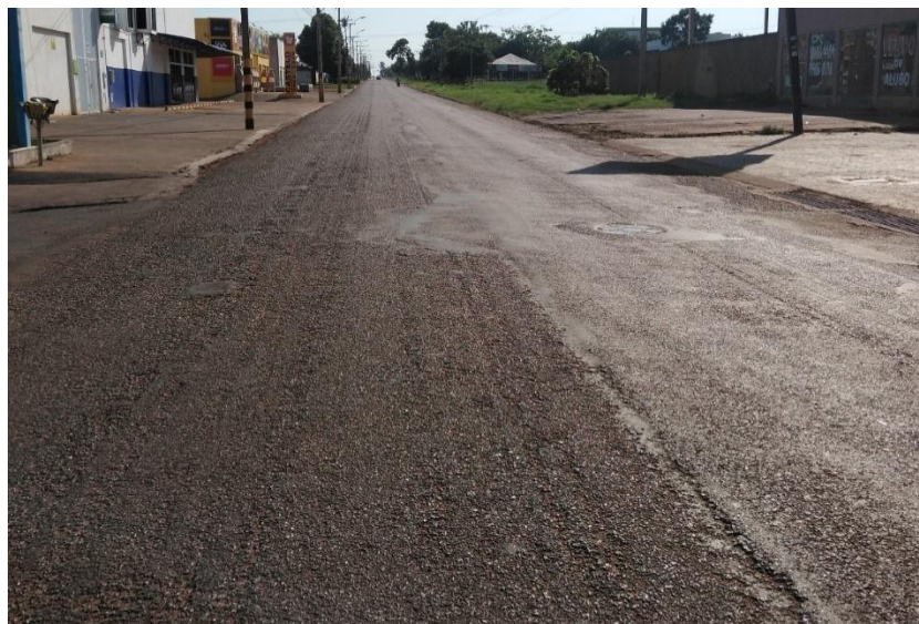
Figura 1 - Via urbana Avenida Mundoca Aires em Porto Nacional - TO
