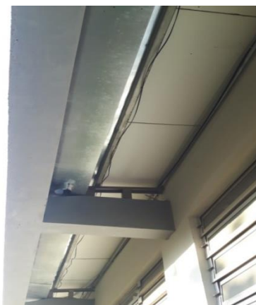
Figura 7 – Bocal da calha
