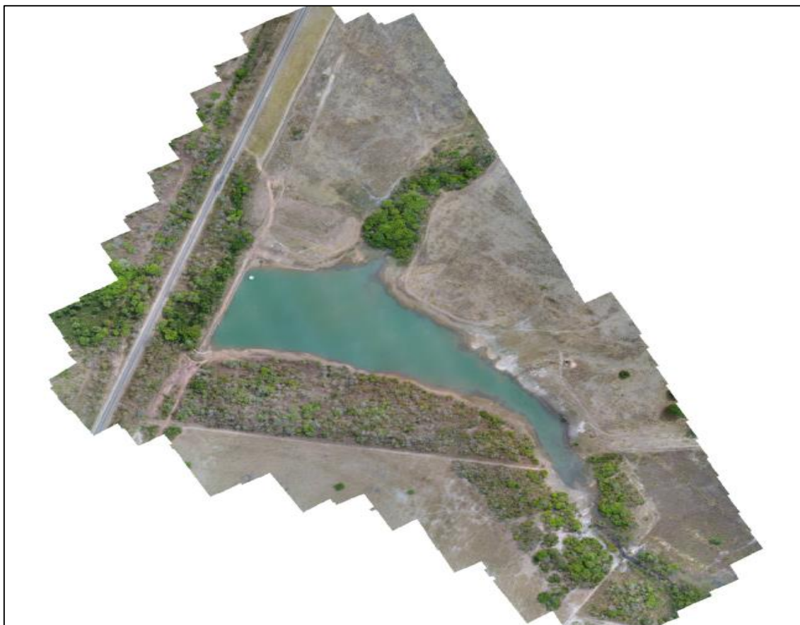
Figura 08 - Seção do barramento Fonte: Arquivo do Autor (2019).
