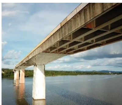
Figura 01: Ponte de Porto Nacional. Fonte: Autores.
