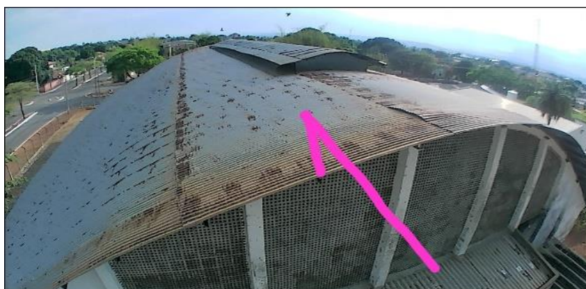
Figura 3. Imagens aérea do telhado
